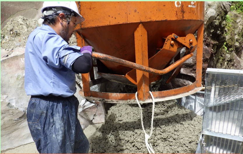
ホッパーを使い生コンを打設しています
