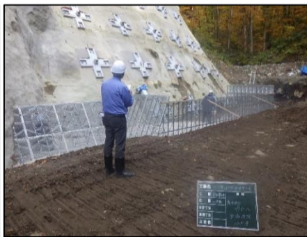
10月度 (水沢第3砂防堰堤)
