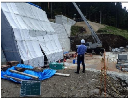
9月度 (水沢第2砂防堰堤)
