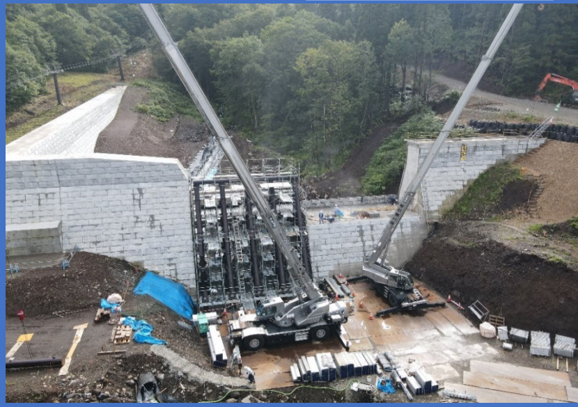
水沢第2砂防堰堤
