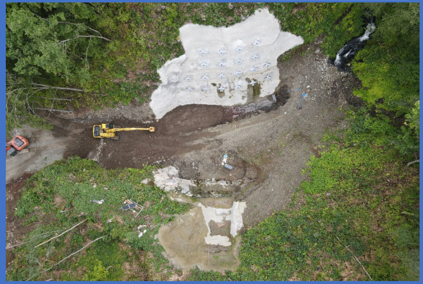
水沢第3砂防堰堤
