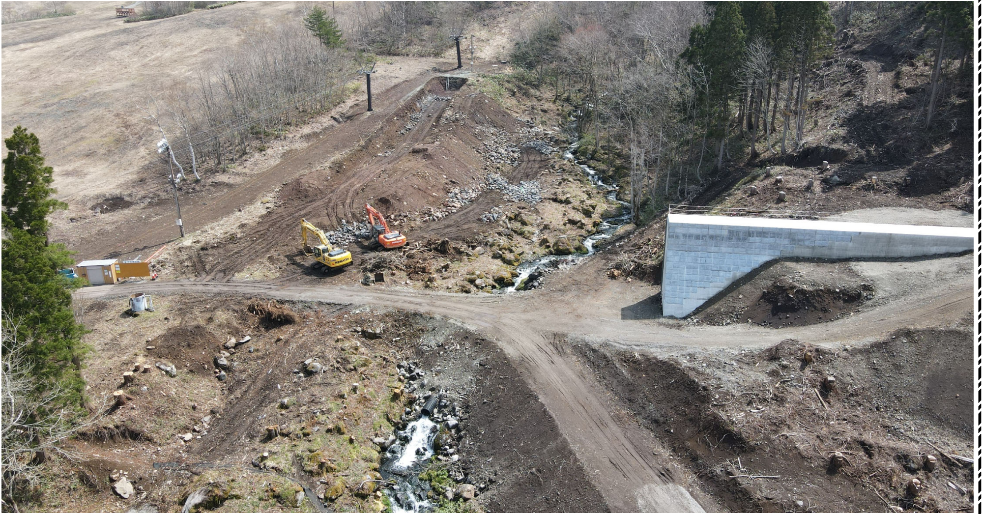
ICT機械による掘削作業
