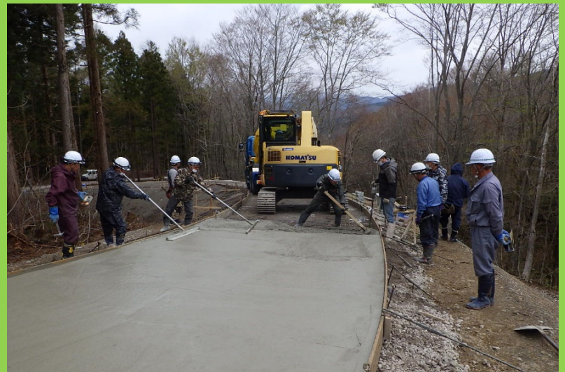
管理用道路のコンクリート舗装
