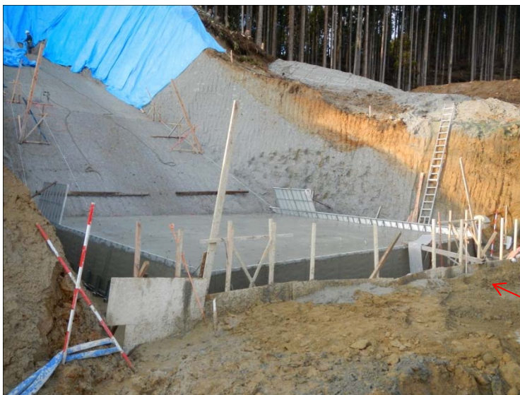
コンクリート打設状況(12月3日撮影)
