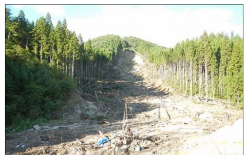
工事着手前(9月27日撮影)
