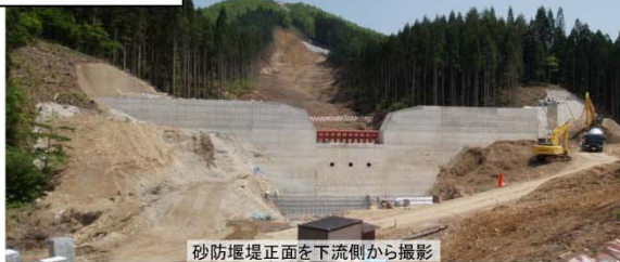
砂防堰堤正面を下流側から撮影
