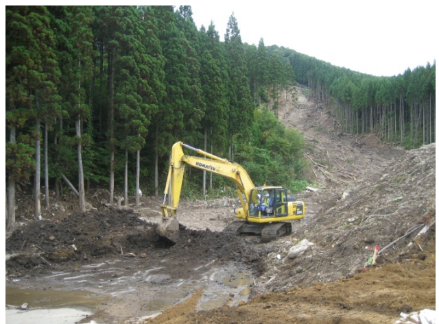
崩壊斜面から流出した崩壊土砂の撤去状況
