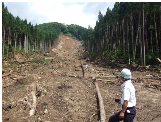
崩壊斜面下部の状況確認
