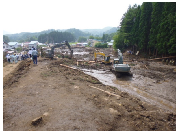
政府調査団による現地調査
