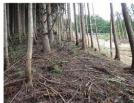
写真Ⅲ-③ 右側部斜面に変状は認められない。
