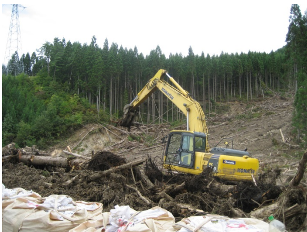
崩壊斜面から流出した流木の撤去状況
