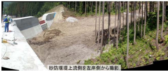
砂防堰堤上流側を左岸側から撮影
