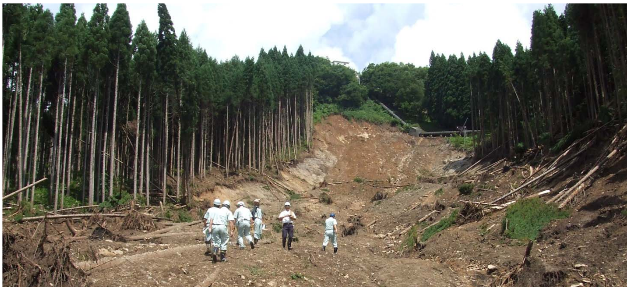
崩壊斜面の調査状況
