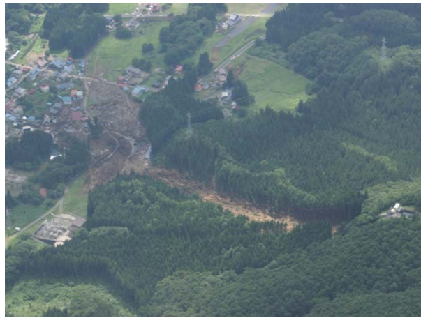
崩壊斜面上部から被災地域等下流側を撮影
