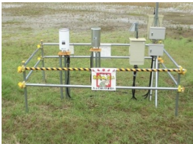
被災箇所近傍の一時避難場所に臨時雨量計を設置
