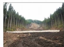
大型土のう設置が完了(延長約50m、2段積、135袋)
