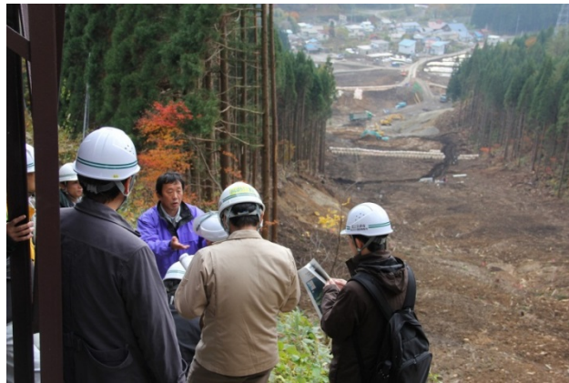
崩壊斜面上部の状況
