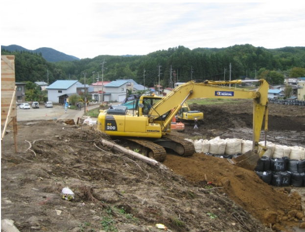
工事は工事用道路の施工から着手
