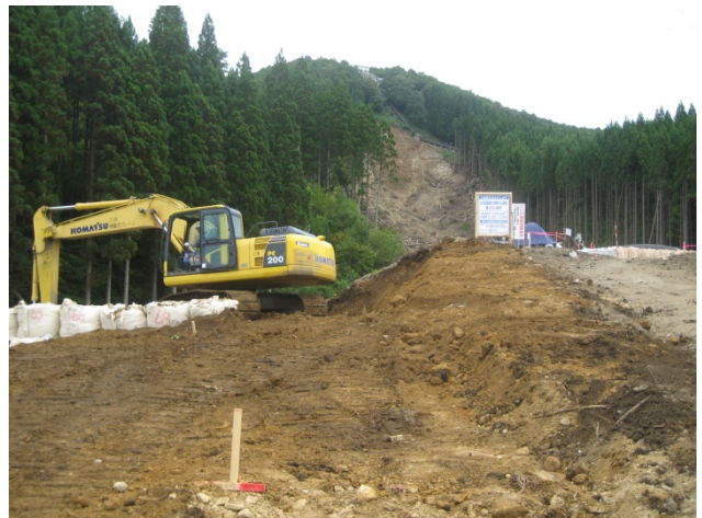
砂防堰堤計画箇所までの工事用道路施工状況
