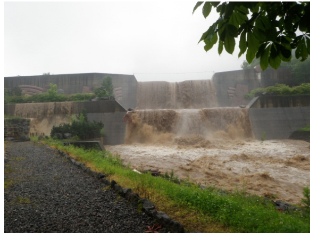
事務所管内の溪流および砂防施設点検を実施
