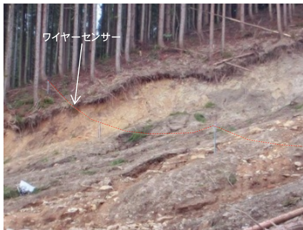
崩壊地中腹にワイヤーセンサーを設置
