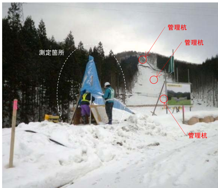
崩壊斜面の測定監視状況
