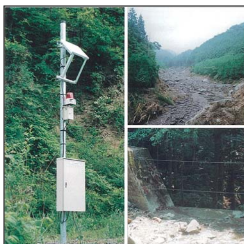
図 4.13 土石流警報装置・ワイヤーセンサ
