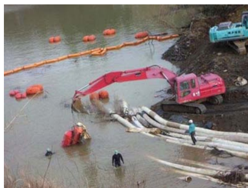
新潟県中越地震におけるポンプによる緊急排水工事
