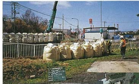
大型土のう設置状況 (4/26撮影)
