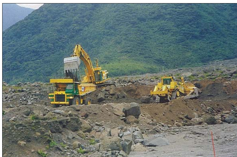
図 1.2 雲仙岳における無人化施工による除石工 出典：火山噴火緊急減災対策砂防計画策定ガイドライン
