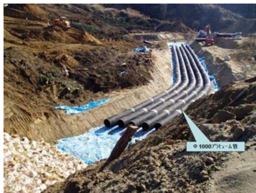
新潟県中越地震における仮排水路掘削工事
