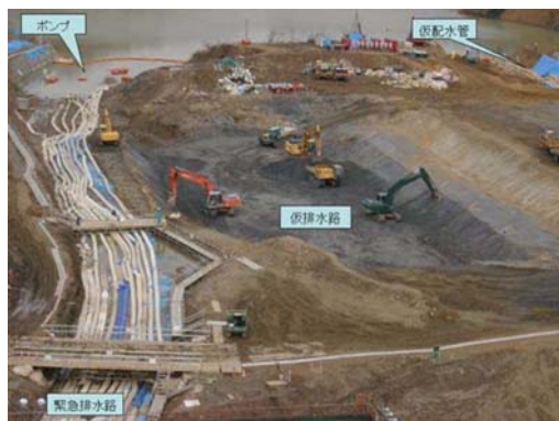
新潟県中越地震における仮排水路掘削工事
