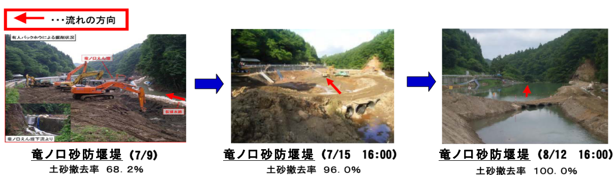
図 1.3 H20 岩手・宮城内陸地震での緊急除石工
