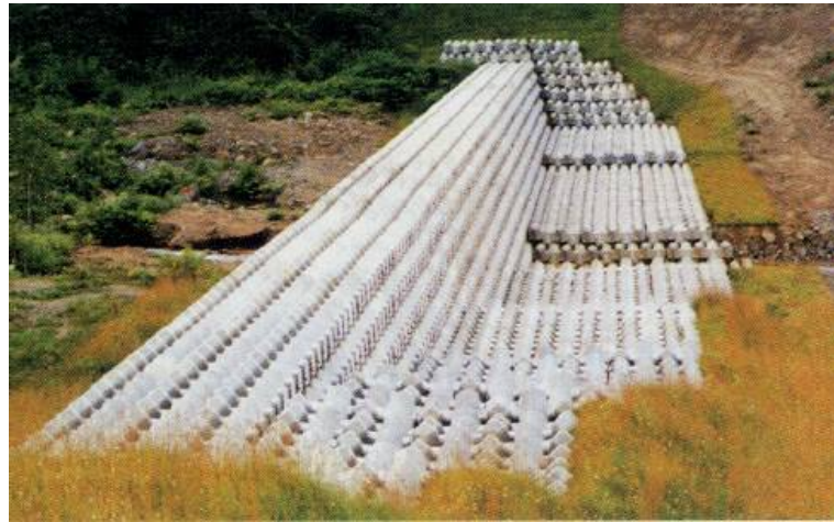
図 1.4 十勝岳におけるブロック積み堰堤 (出典:火山噴火緊急減災対策砂防計画策定ガイドライン)
