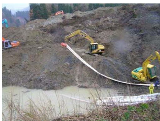
新潟県中越地震におけるポンプによる緊急排水工事
