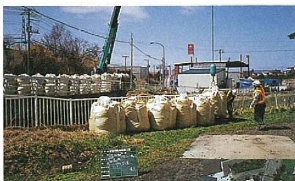
大型土のう設置状況 (4/26撮影)
