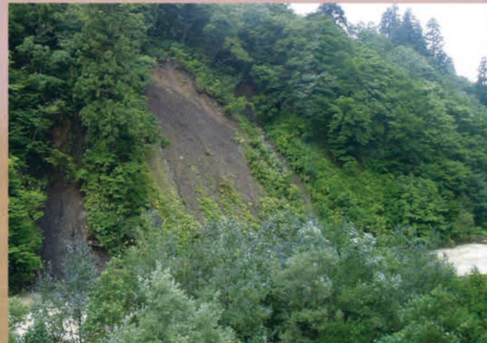
生保内川沿いの崩壊地
