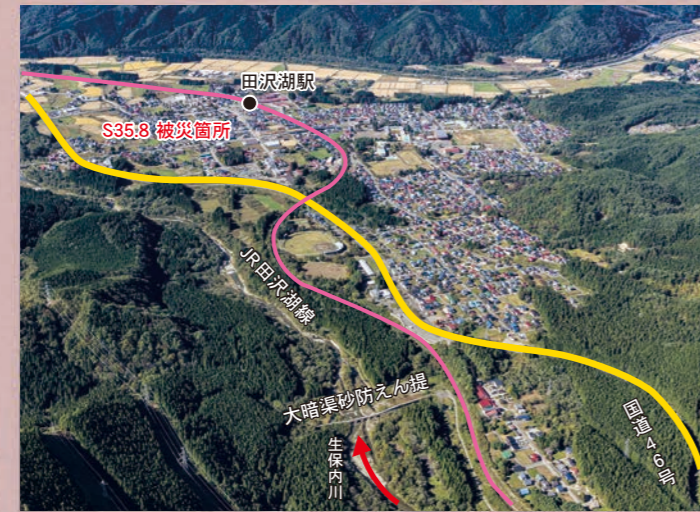
現在の航空写真から見る昭和35年8月の被災箇所
