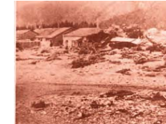
田沢湖町被害状況
