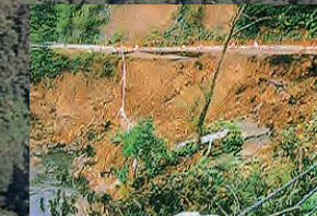
台風による崩落状況/西山・生保内線(平成3年)
