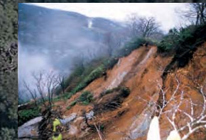
先達川上流土砂崩落状況(平成9年)
