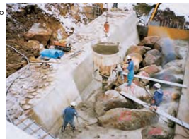
水叩工転石投入後のコンクリート打設状況
