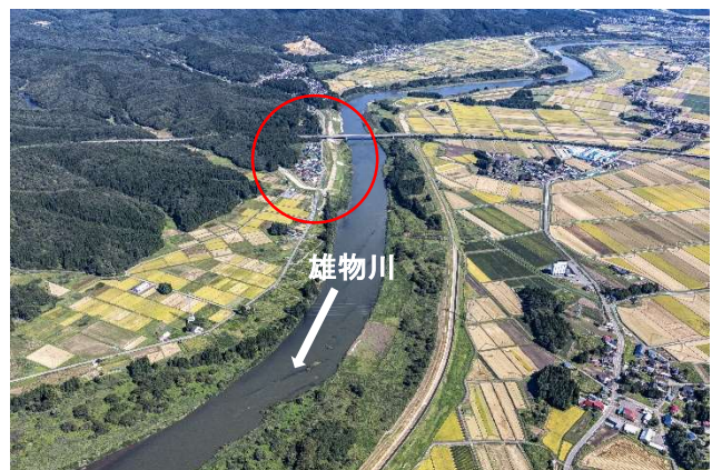
堤防(輪中堤)の整備状況 (令和5年9月23日撮影)
