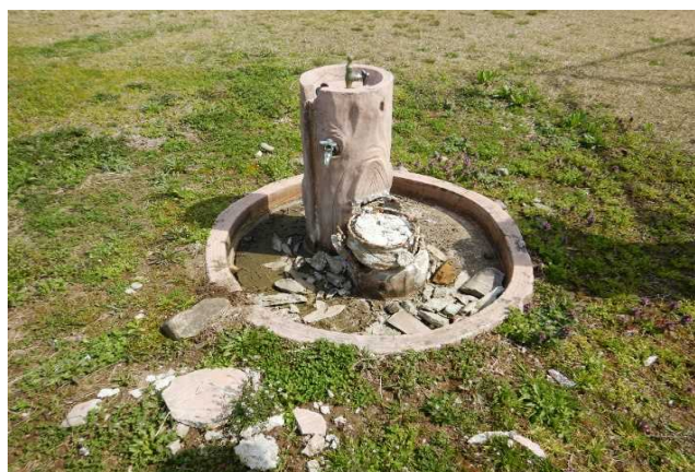
手洗い設備の損傷
