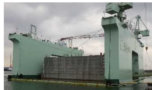
▲ 防波堤として使用する『ケーン(※)』の製作状況 ※ケーン: 防波堤を形成するコンクリートの箱
