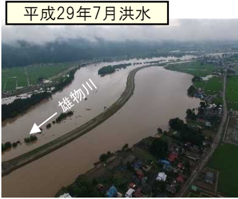
[雄物川本川の浸水状況]
