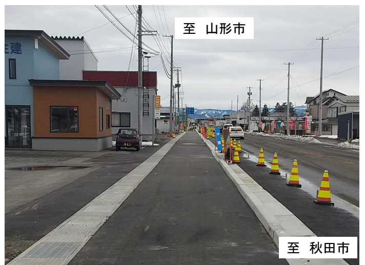
拡幅後の歩道の状況
