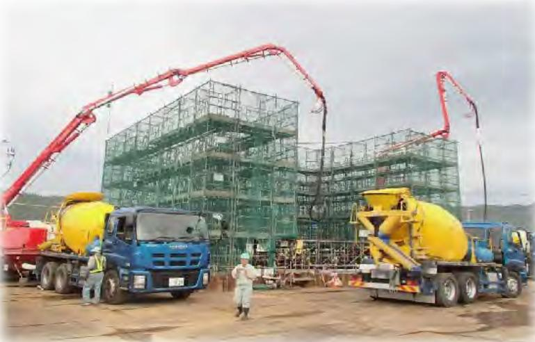
橋台のコンクリート打設状況
