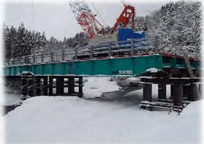
仮橋の桁架設状況
