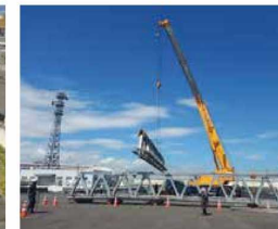
応急組立橋の架設点検
