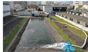
排水ポンプ車の操作訓練 （危機管理（機械）エキスパート講習）
