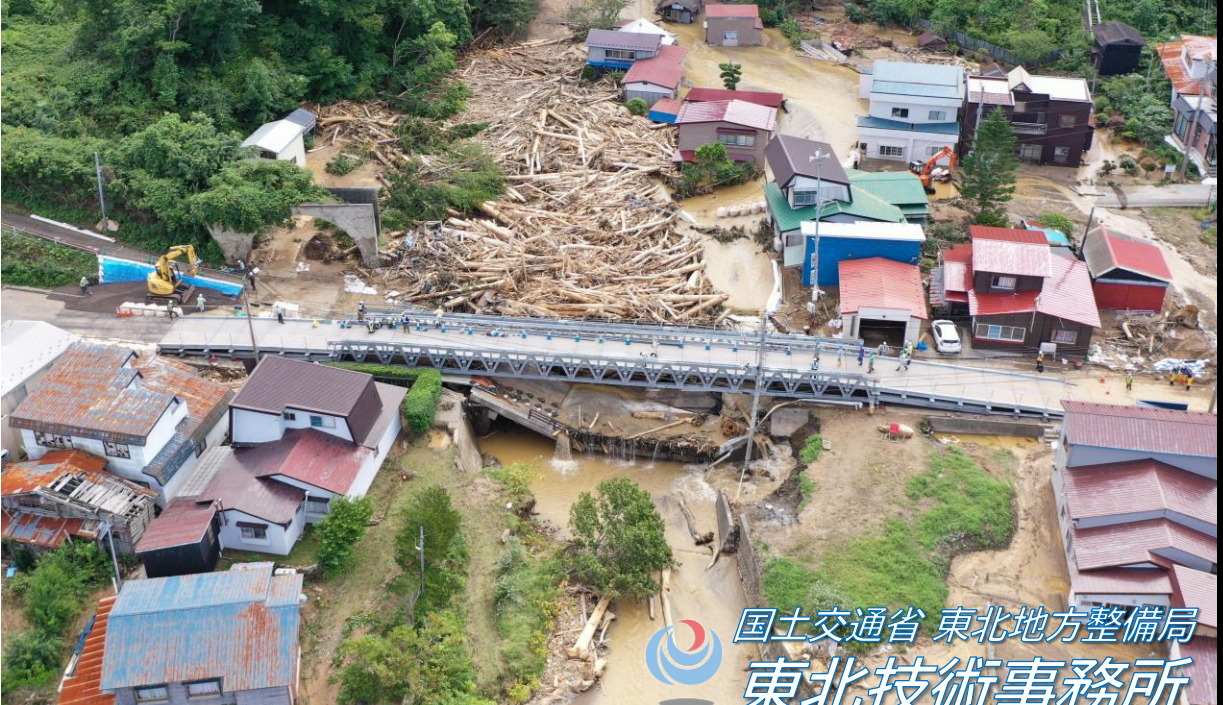
令和3年8月(青森県むつ市) 大雨により、青森県むつ市国道279号に架かる小赤川橋が崩落したため、応急組立橋を派遣
