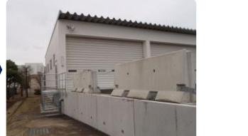
対策後(高上した格納庫)
