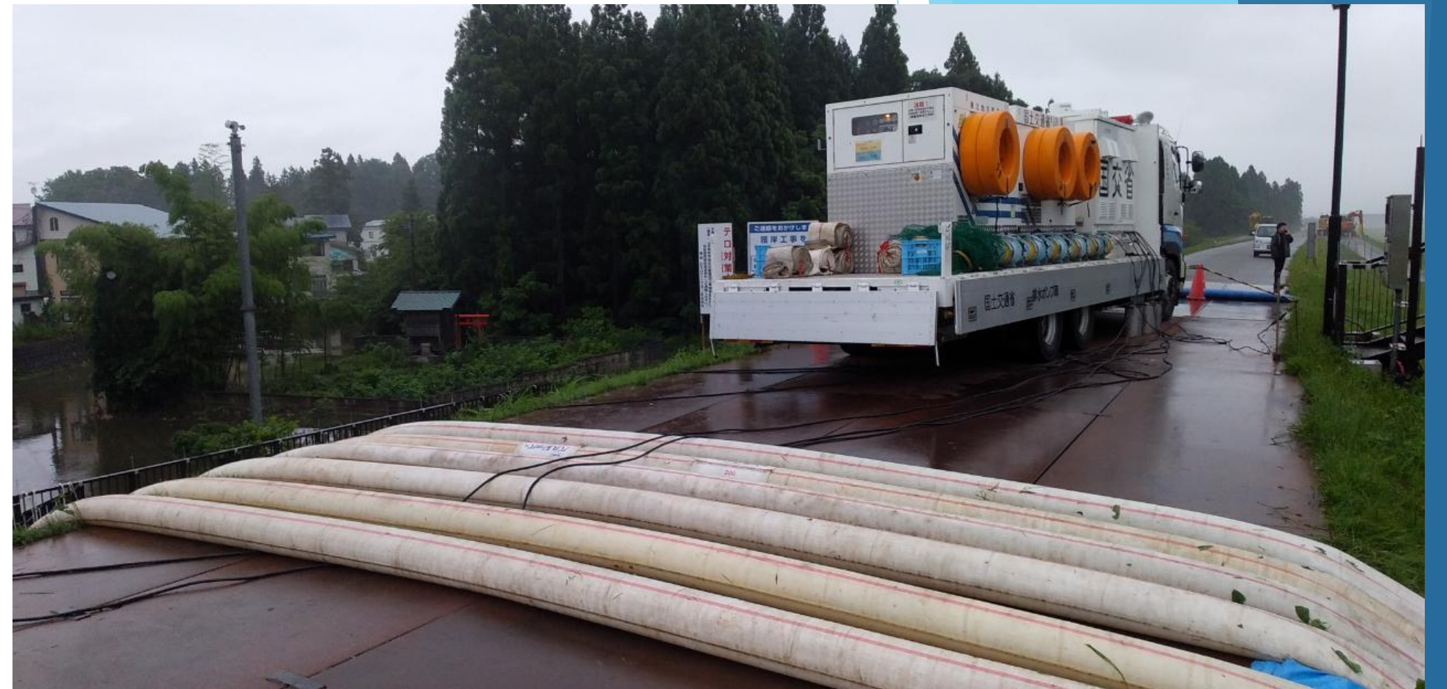
場所:秋田県大仙市神宮寺字上新川中島地内(後川排水樋門) 機械:排水ポンプ車(23-4251) 照明車(23-4283) 期間:令和6年7月9日～11日
