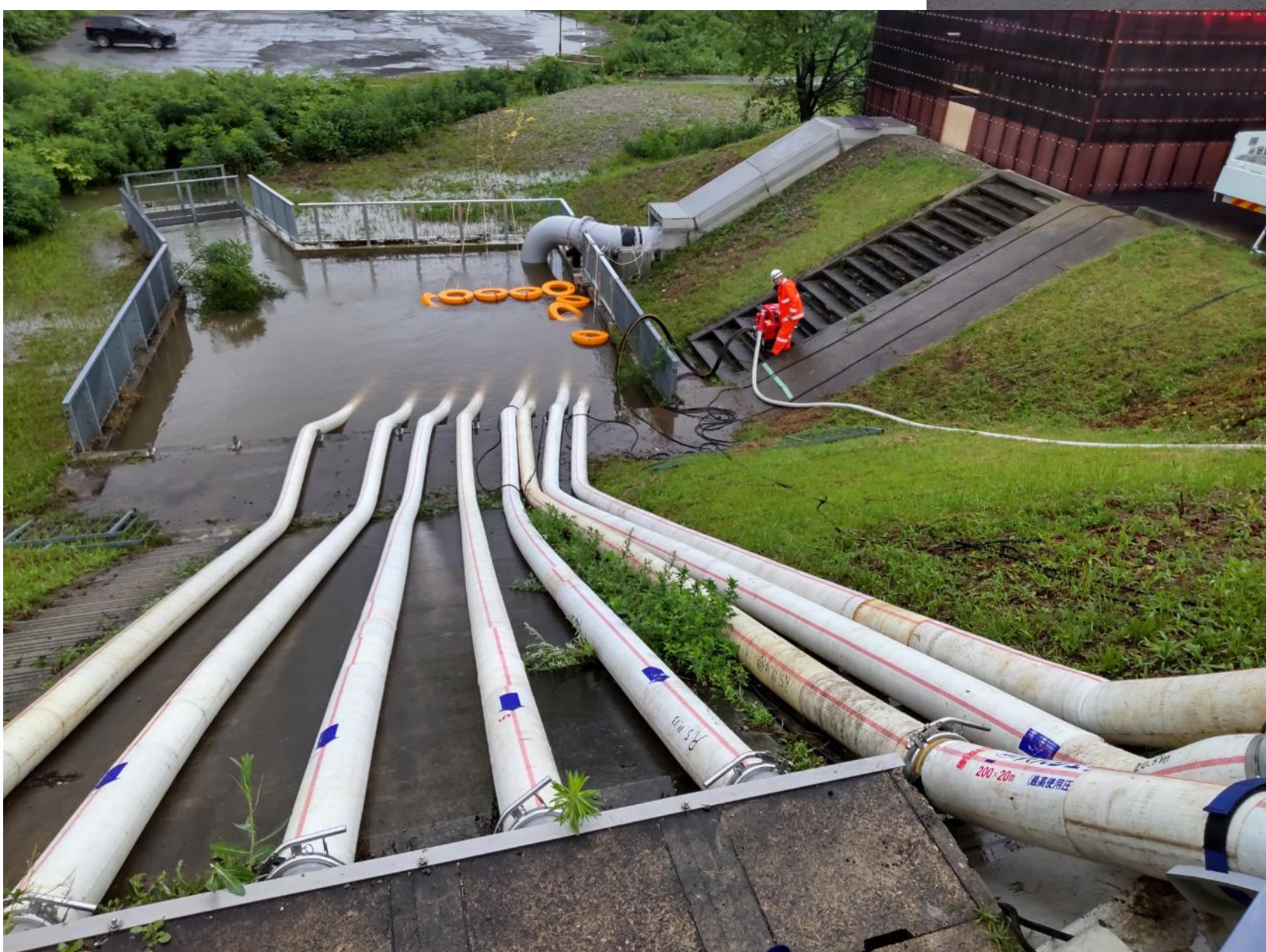
場所:秋田県大仙市大曲浜町地内(浜町樋管) 機械:排水ポンプ車(23-4250) 期間:令和6年7月9日
