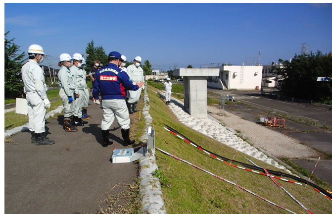
堤防法面のはらみ出しの計測方法について説明
