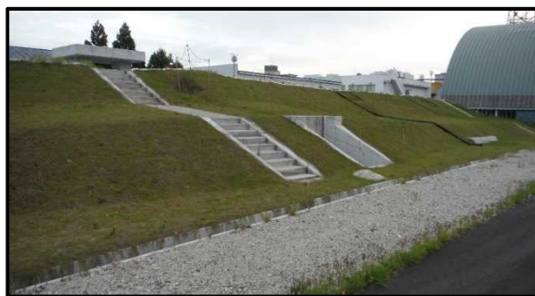
除草後(川裏側)
