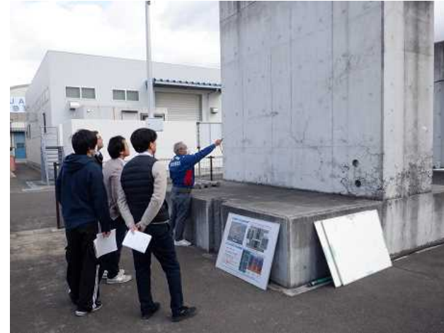
不適切施工について
