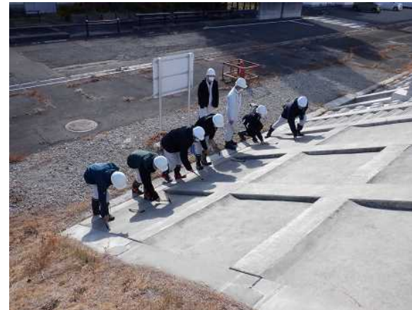
打音による護岸の空洞化の確認
