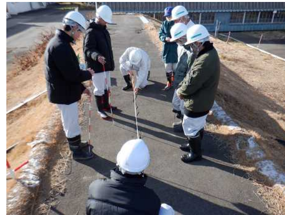
堤防の亀裂の計測
