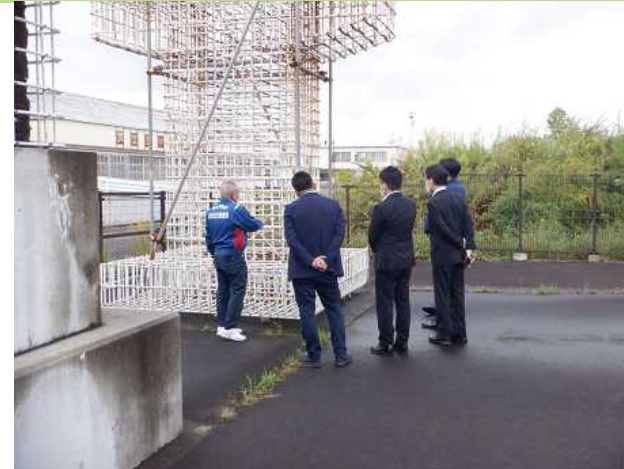
鉄筋の補強について
