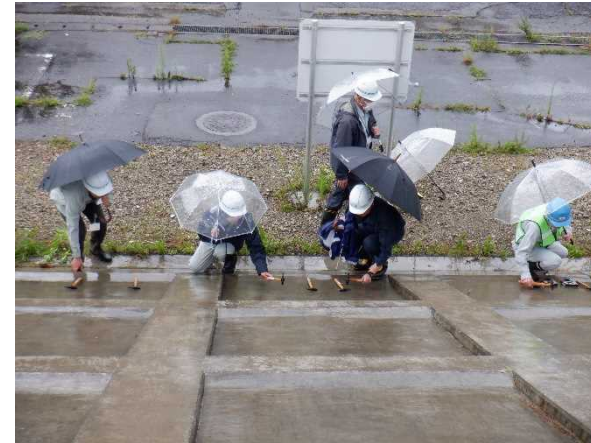
打音による護岸の空洞化の確認
