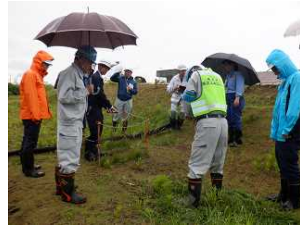
貫入棒による堤体の緩みの確認
