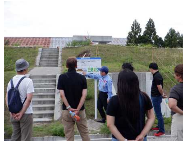
漏水のシステムについて
