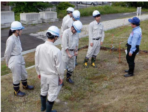
貫入棒による堤体の緩みの確認
