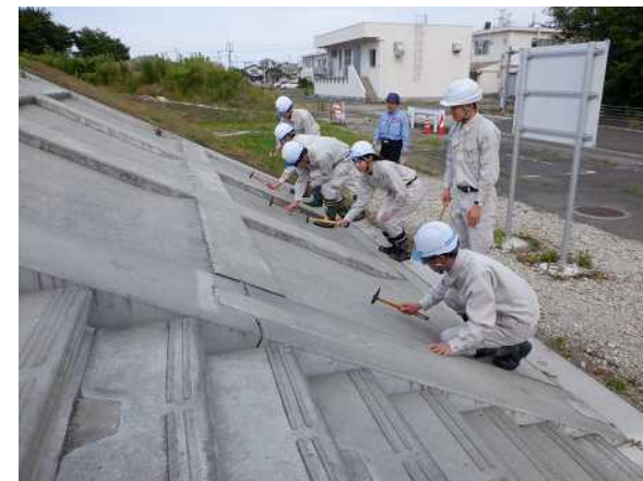
打音による護岸の空洞化の確認
