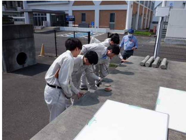
不適切施工について
