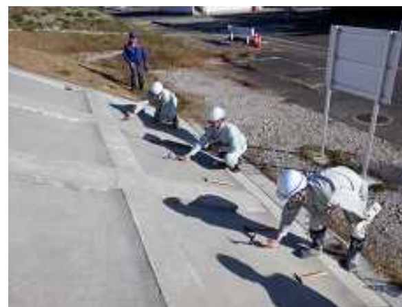
打音による護岸の空洞化の確認
