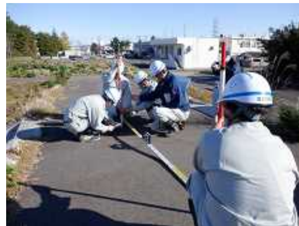
堤防の抜け上がりの計測
