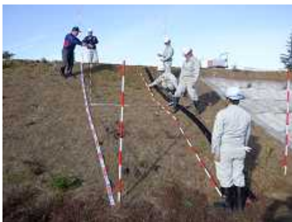
堤防のはらみ出し・寺勾配の計測
