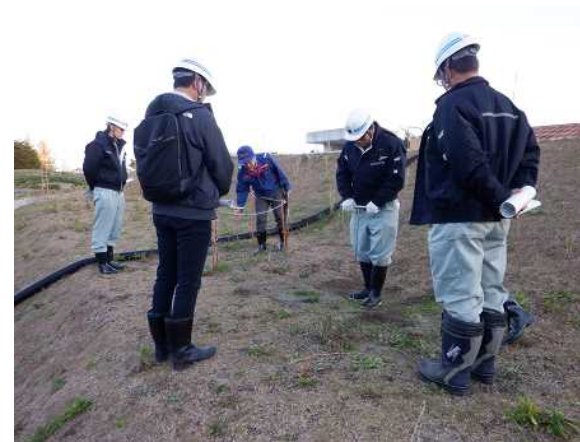
貫入棒による堤体の緩みの確認
