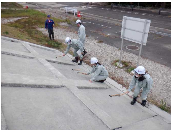
打音による護岸の空洞化の確認
