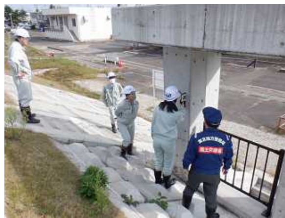
樋門門柱の傾斜の計測
