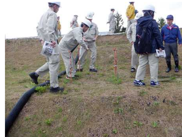
貫入棒による堤体の緩みの確認
