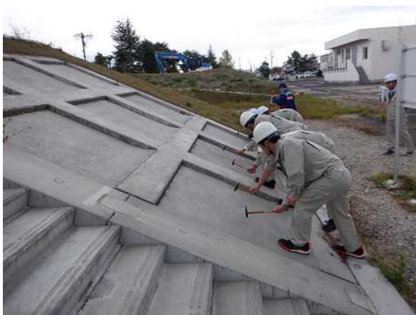
打音による護岸の空洞化の確認
