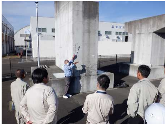
不適切施工について
