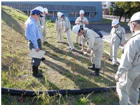
貫入棒による堤体の緩みの確認
