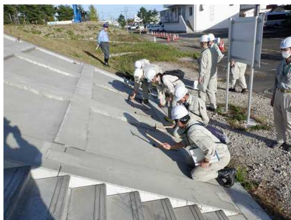
打音による護岸の空洞化の確認
