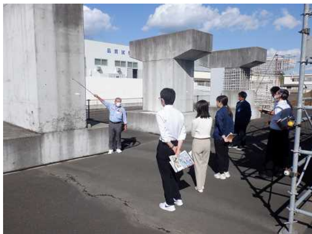
不適切施工について
