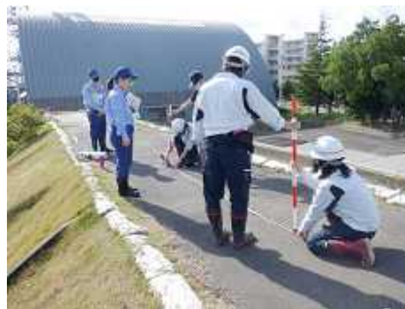
堤防の亀裂の計測
