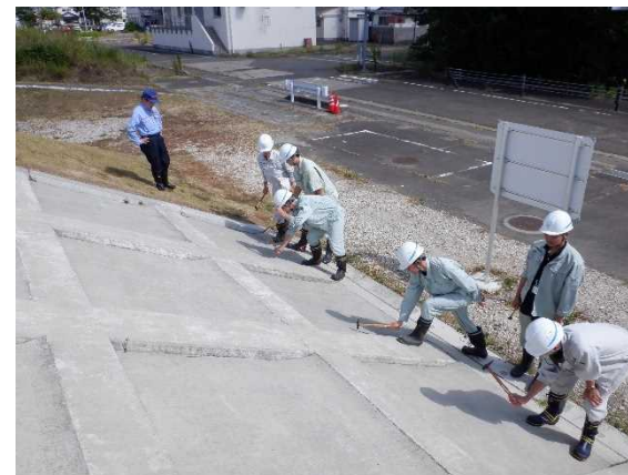
打音による護岸の空洞化の確認
