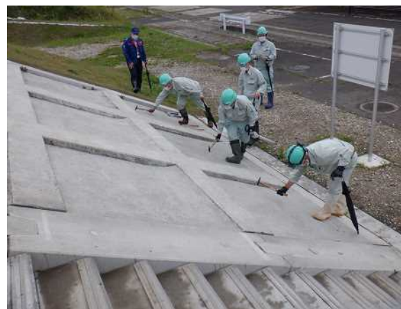
打音による護岸の空洞化の確認
