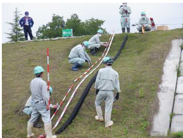
堤防のはらみ出し・寺勾配の計測
