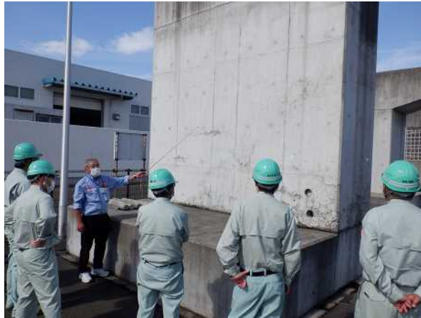
不適切施工について
