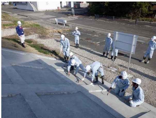
打音による護岸の空洞化の確認
