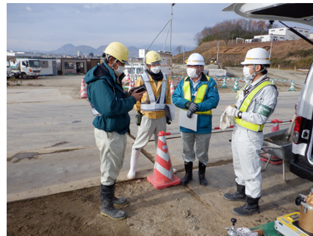
打設配合確認
