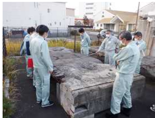
損傷(劣化)モデル:RC床版について
