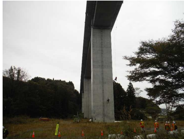
ロープ高所作業点検中の様子
