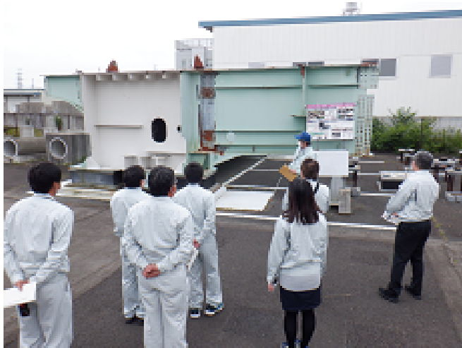
被災した橋梁上部工(鋼箱桁)について
