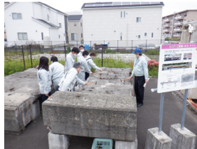
劣化したRC床版で打音検査体験
