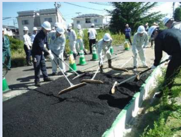
実習：アスファルト人力舗装
