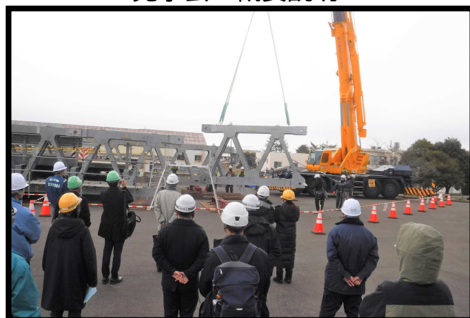
架設状況（主構架設の様子）
