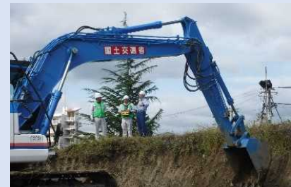
実技操作：土砂掘削
