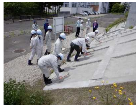
打音による護岸の空洞化の確認
