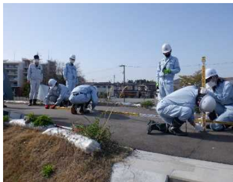
堤防の抜け上がりの計測
