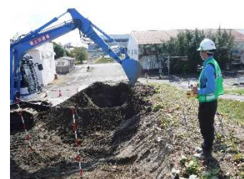
実技操作：土砂掘削
