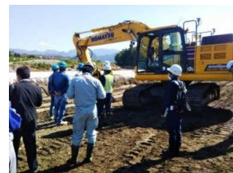
実習：ICT建機操作実習
