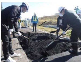
実習：アスファルト人力舗設
