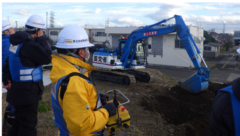
簡易遠隔操縦装置(ロボQS)を使用したバックホウの遠隔操作訓練
