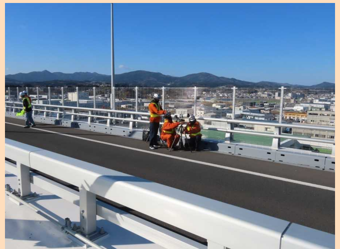
▲超望遠レンズによる高層構造物の外観検査技術による点検状況（主塔上部側面）
