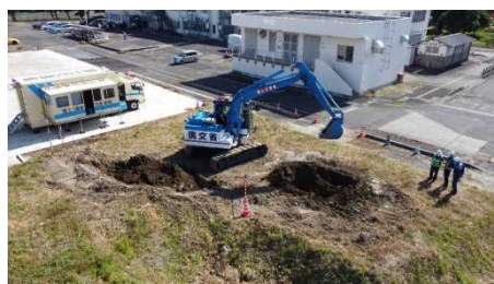
実技操作：土砂掘削、埋め戻し、のり面整形
