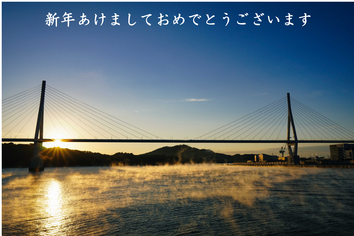
気仙沼湾横断橋と気嵐 写真提供: 仙台河川国道事務所
