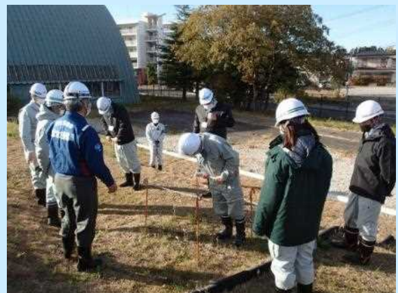
貫入棒による堤体の緩み状態の調査
