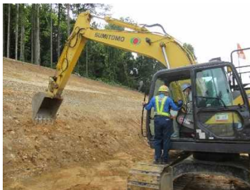
実習：ICT建設機械の操作
