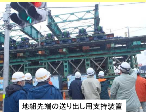
上部工送り出し架設工法のMR動画
