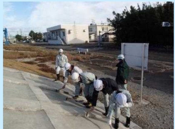
打音による護岸の空洞化調査
