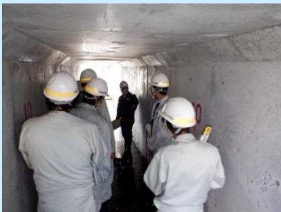
樋門函体内での調査
