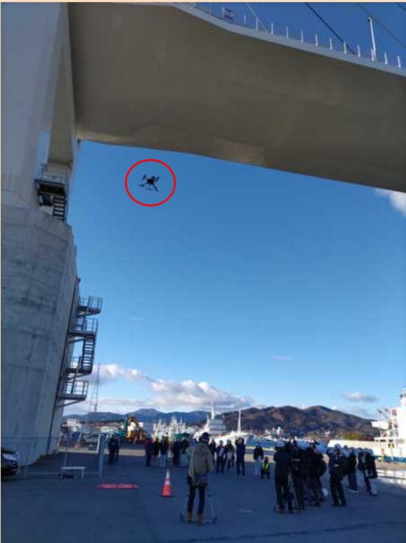
▲ドローン・AIを活用した橋梁点検・調書作成支援技術による主桁の塗膜状態の画像取得状況（主塔下部側面・正面、主桁下面）【公開状況】
