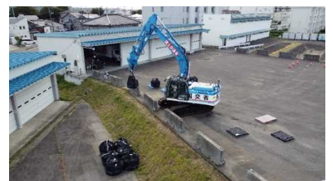
実技操作：大型土のう設置作業
