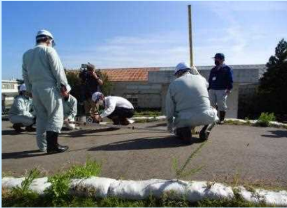
堤防の抜け上がりの計測
