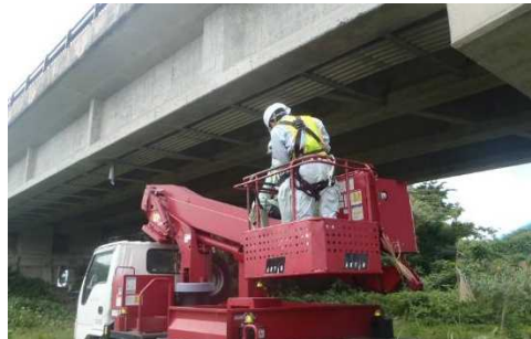
橋梁点検現地実習（新岩出山大橋）
