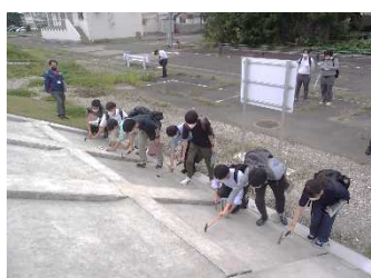
河川護岸の空洞化調査を体験
