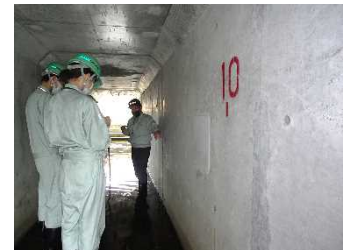
樋門内部のひび割れ調査を体験
