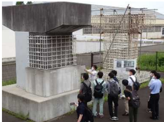
橋脚耐震補強について学習
