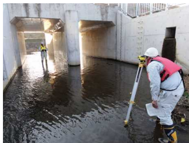
▲排水樋門内の沈下量計測
