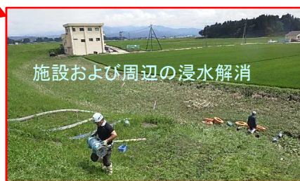
排水作業後(大石田町)
