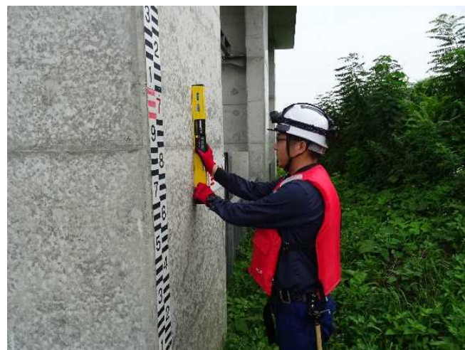
▲門柱の傾倒計測
