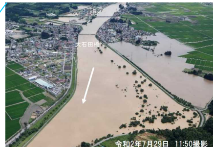
大石田町 大石田橋周辺(7月29日14時)
