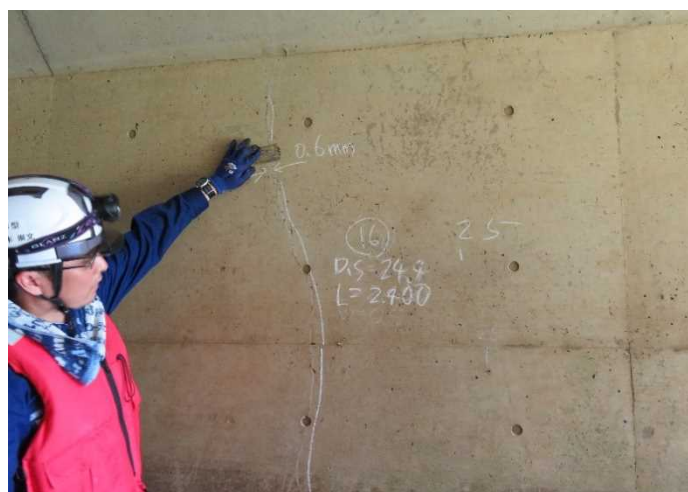
▲排水樋門内のクラック計測
