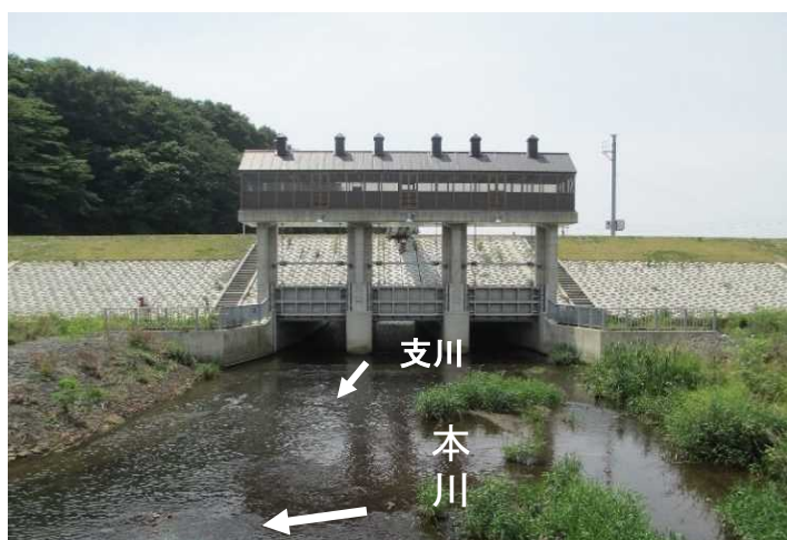
▲排水樋門全景
