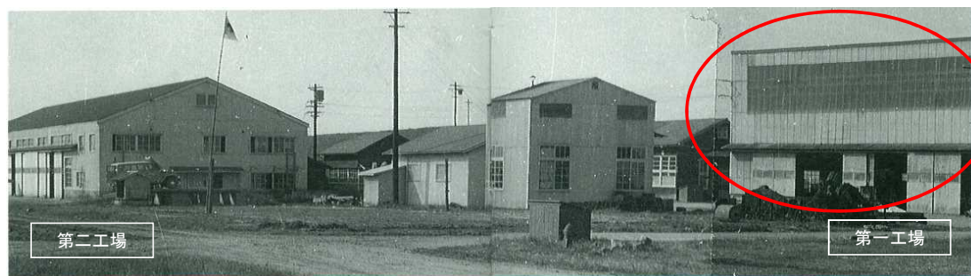
写真-② 採光面を大きく取った第一工場（右端）
