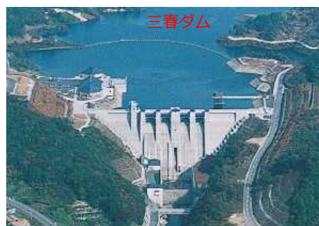
三春ダムです。三春ダムはE L C M工法で作られています。E L C Mとは拡張リア打設のことで、有スランプコンクリートを複数ブロック同時に面状に打設する工法です。
