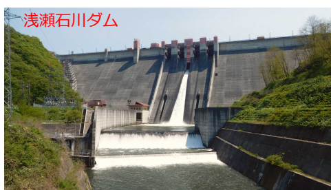
浅瀬石川ダムです。コンクリートをサイコロ状に打ち重ねていく柱状ブロック工法で作られました。
