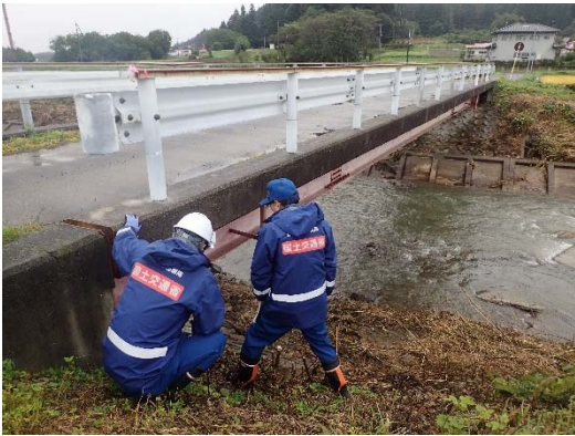
【橋梁点検状況(白河市内松橋)】
