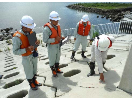
河川管理施設点検現地実習
