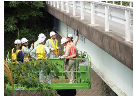
橋梁点検現地実習
